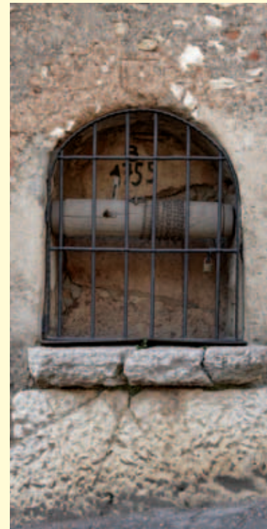
Pozzo in Via San Nicola (foto VL).
