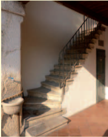
Pilastrino e scala in pietra nel rustico della Villa Labus (foto PV).
